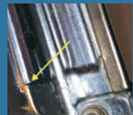
Molempien takaovien ikkunoiden ohjauskiskoissa oli ruostetta.
